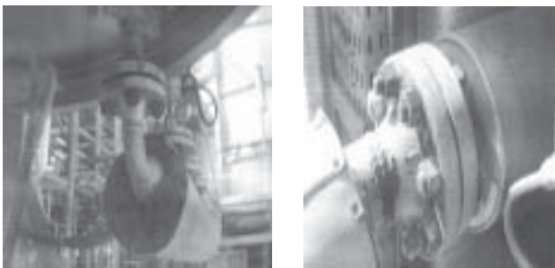
شکل ۲ - فلنچ‌های فاقد عایق
